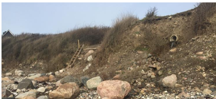
Figur 3-7 Del av sträckan för planerad stenskoning vid Brovägen: rasbrant med provisorisk trappa och blottlagda dagvattenrör. Bild tagen 2019-03-12.
