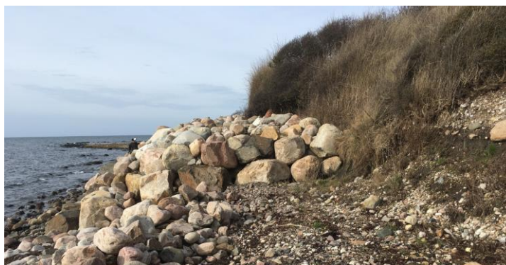
Figur 3-8 Nyligen renoverad stenskoning norr om den planerade stenskoningen vid Brovägen. Bild tagen 2019-03-12.
