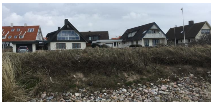
Figur 3-12 Ytterligare en delsträcka längs Strandlyckevägen som helt saknar erosions-skydd och därmed uppvisar en tydlig erosionsbrant.
