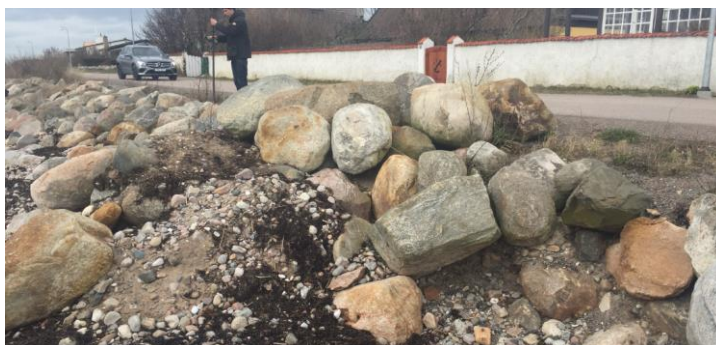
Figur 3-11 Raserad stenskoning längs Strandlyckevägen. Bakom stenskoning syns Strandlyckevägen. Bild tagen 2019-03-12.
